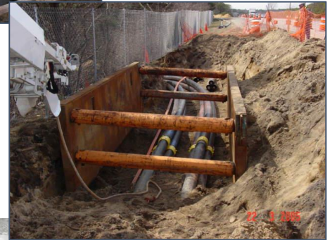
Conduit Installation
