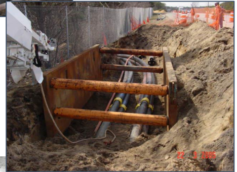
Instalación de conductos
