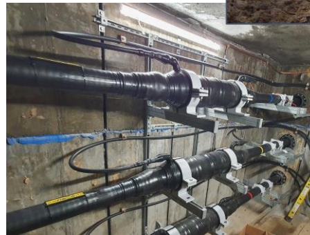
Empalme de cables
