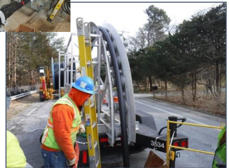
Instalación de cables
