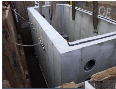
Instalación de la bóveda
